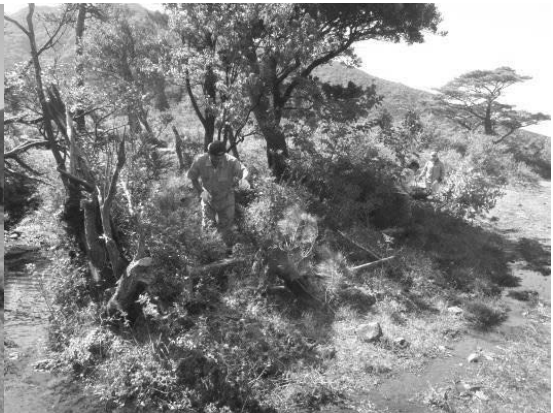
草刈り等除去作業
