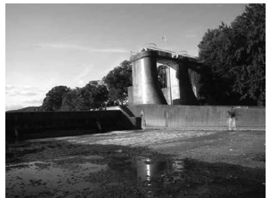
No.42 寅天井堰 (2009年9月26日) 水門
