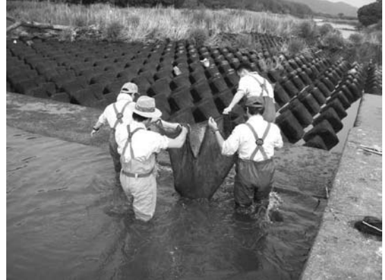
No.38 寅天井堰 (2009年5月26日)
