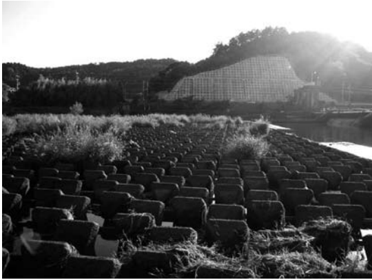
No.43 寅天井堰 (2009年9月26日)
