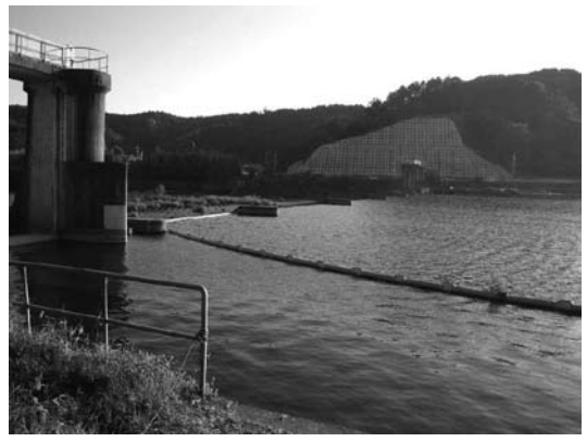
No.44 寅天井堰 (2009年9月26日)
